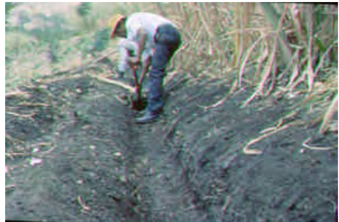
Figura 74. Zanja para captar sedimento.
